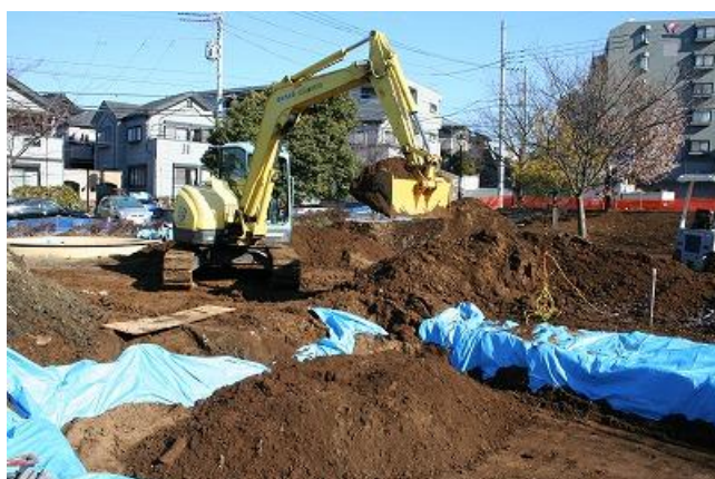
▲我孫子後田公園の除染工事
