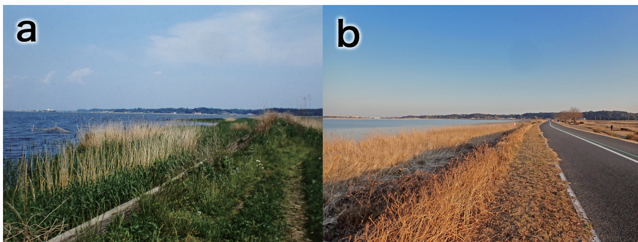
図 7. 手賀沼自然ふれあい緑道設置前後の染井入落付近の遊歩道の a: 1987 年 5 月 21 日と b: 2022 年 2 月 3 日の景観。堤防上の未舗装の歩道は幅員が拡張された舗装道路となった。撮影地は手賀沼南岸東部の鷺野谷新田。
