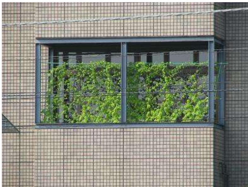
壁面緑化の外観
