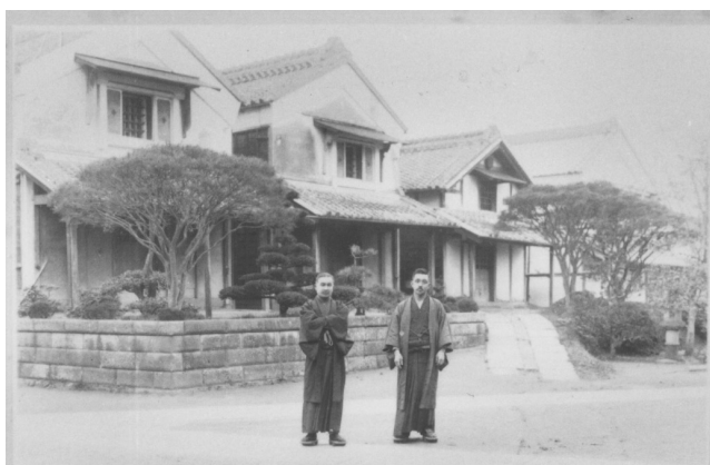
写真34 昭和6年に撮影された旧井上家住宅 3棟の蔵が水塚の上に建っている
