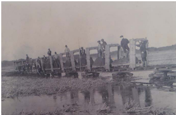
写真25 トロッコを使用した干拓の様子
