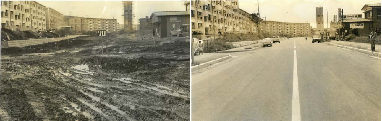
湖北台団地造成の様子(昭和40(1965)年ごろ) 左(写真53):造成中 右(写真54):造成後
