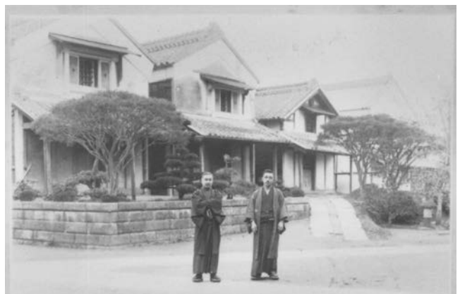
写真34 昭和6年に撮影された旧井上家住宅 3棟の蔵が水塚の上に建っている
