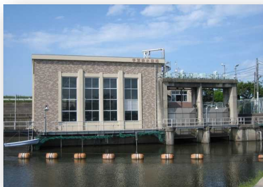
手賀排水機場
