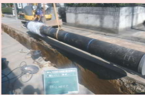
耐震管(ダクタイル鋳鉄管)布設状況
