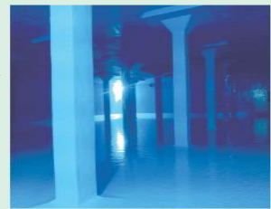
湖北台浄水場3号配水池内部
