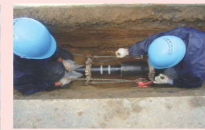
耐震管(ダクタイル鋳鉄管)接合状況
