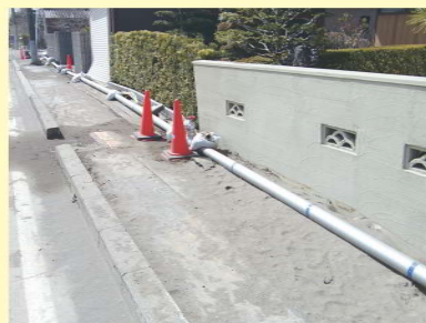
東日本大震災時に布設した仮設管路
