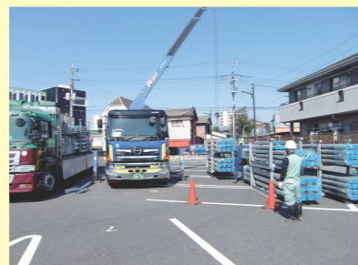
東日本大震災時の緊急資材の搬入
