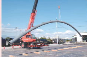
耐震管(ダクタイル鋳鉄管)の吊上げ実験 (画像提供:一般社団法人日本ダクタイル鋳管協会)
