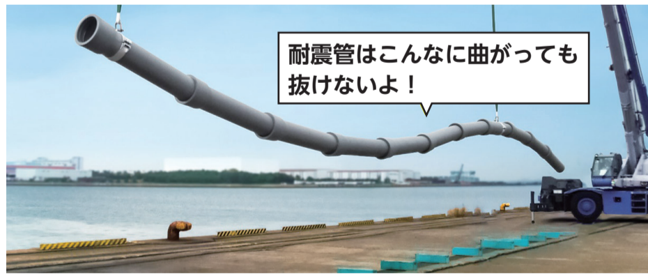
画像提供：日本ダクタイル鉄管協会
