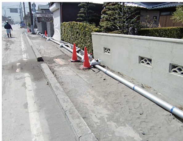
平成23年3月 東日本大震災 応急復旧状況
