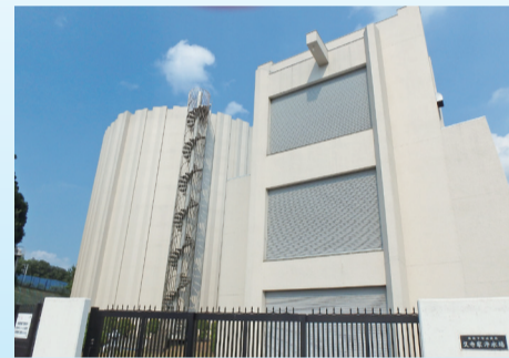
▲久寺家浄水場
