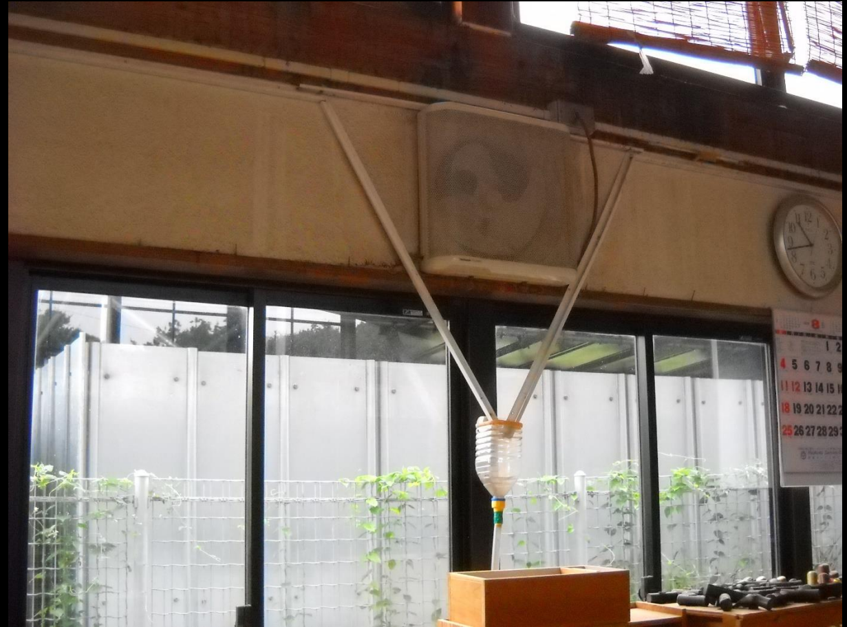
内壁に樋を回しペットボトルで受ける設備を自作
