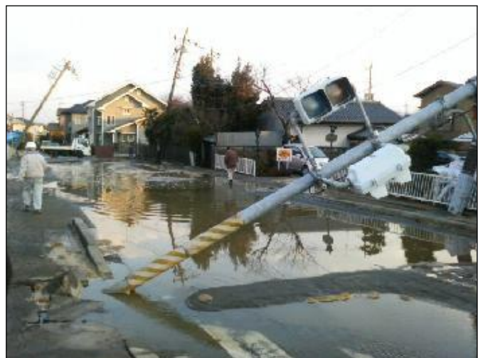
〈東日本大震災による液状化被害〉
