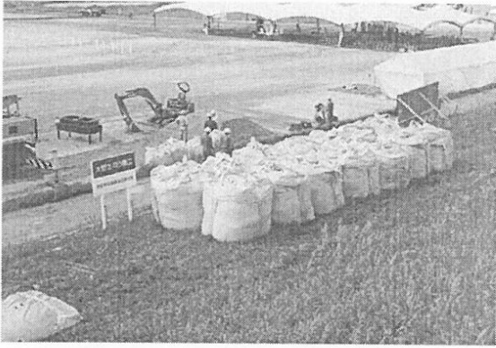
〔大型土のう工〕
