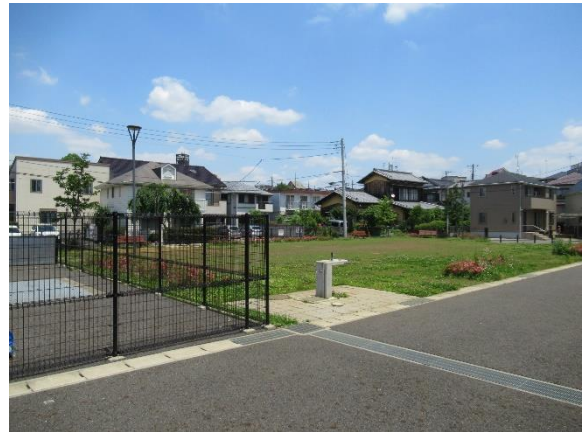
地下式調整池の上部に整備された我孫子4丁目いこいの広場
