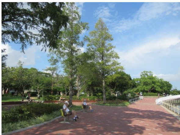
舗装の再整備(手賀沼公園)
