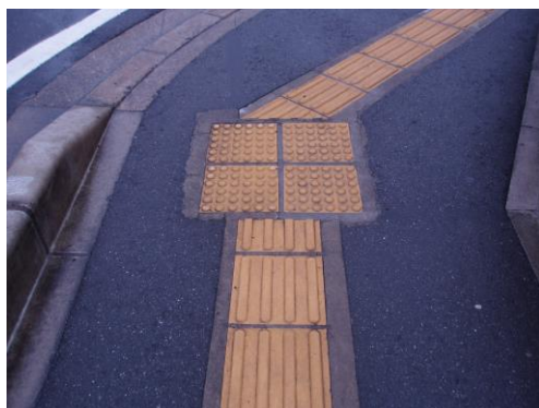
視覚障害者誘導用ブロック
