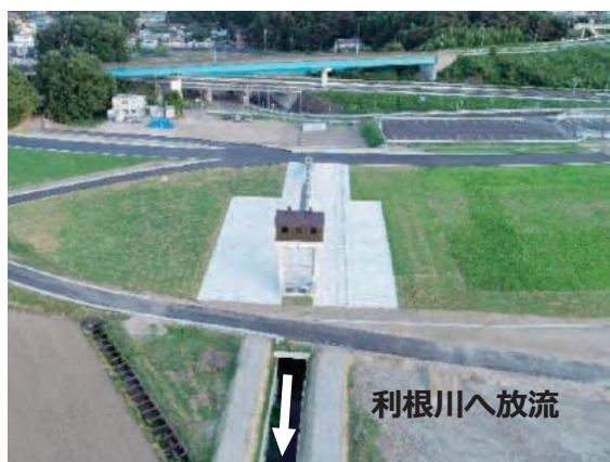
排水施設（後田樋管）
