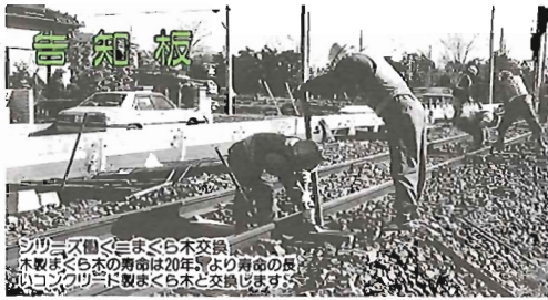
告知板 シワズ木製まくら木の寿命は20年、より寿命の長いコンクリート製まくら木と交換します。
