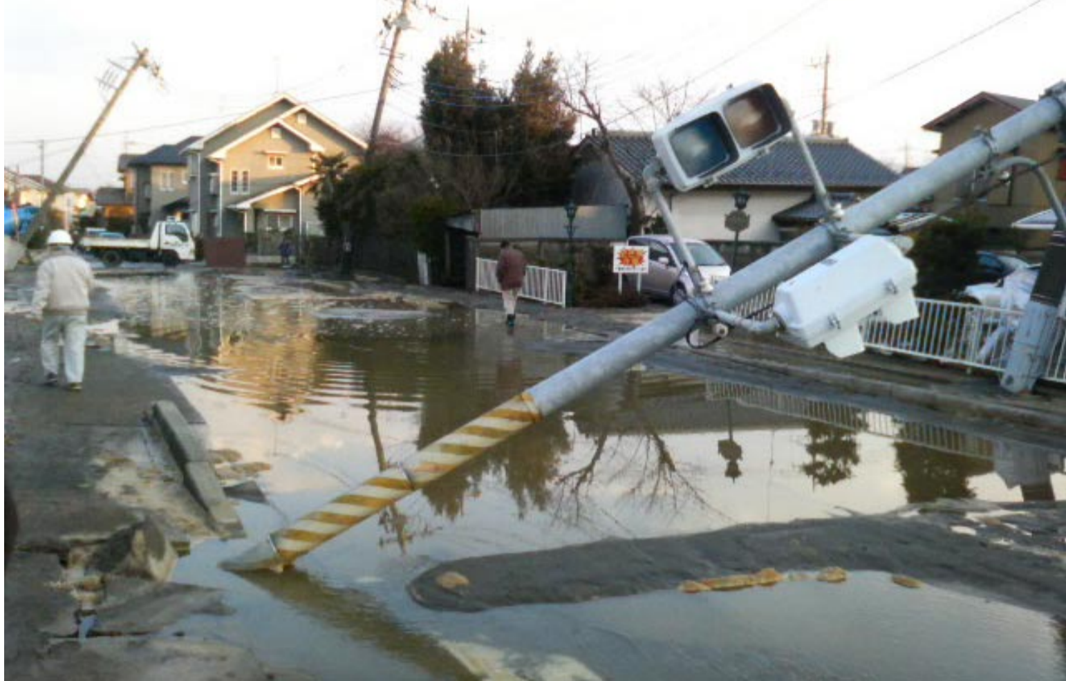
◀液状化現象で傾いた信号と電信柱（布佐・都地区）
