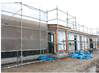
▲建設中の小規模改良住宅
