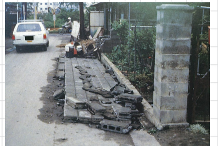
▲控壁がなく道路へ倒壊した塀
