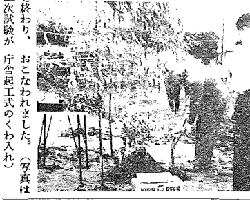
倉舎工事の進展
