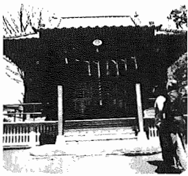
▲すっかり生まれかわった不動堂
