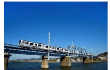
内房線 上総湊・竹岡駅間
