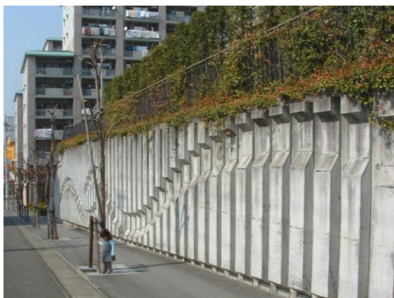
▲擁壁を工夫することにより、うるおいを与えています。(川崎市)
