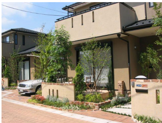
▲外壁の色彩に配慮するとともに、緑を配しています。（船戸2丁目）
