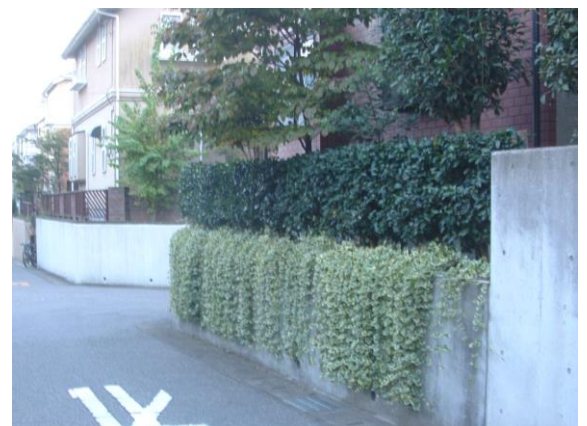
▲擁壁につる性植物を組み合わせることにより、印象をやわらげています。(栄)
