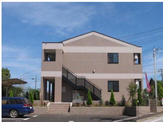
▲外壁や屋外階段、外回りの色彩に配慮し、一体感を与えています。(中峠)
