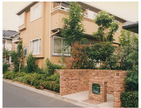
▲ゴミ置き場に周辺のまちなみと調和する色彩のレンガを用いるとともに、前面に壁を立ち上げ、ゴミが目立たなくするようにしています。(佐倉市)
