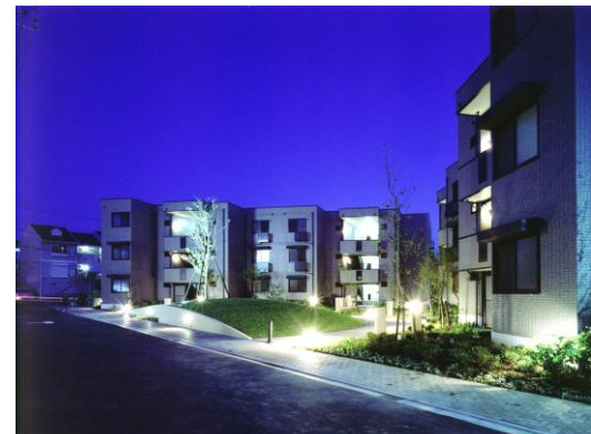
▲建築物と一体的にオープンスペースを計画するとともに、夜間の魅力ある景観づくりにも配慮しています。(天王台4丁目)
