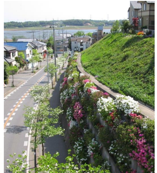
▲高低差の大きい擁壁を緑化ブロックとすることにより、圧迫感を軽減するとともに、手賀沼への眺望にも配慮しています。(高野山)
